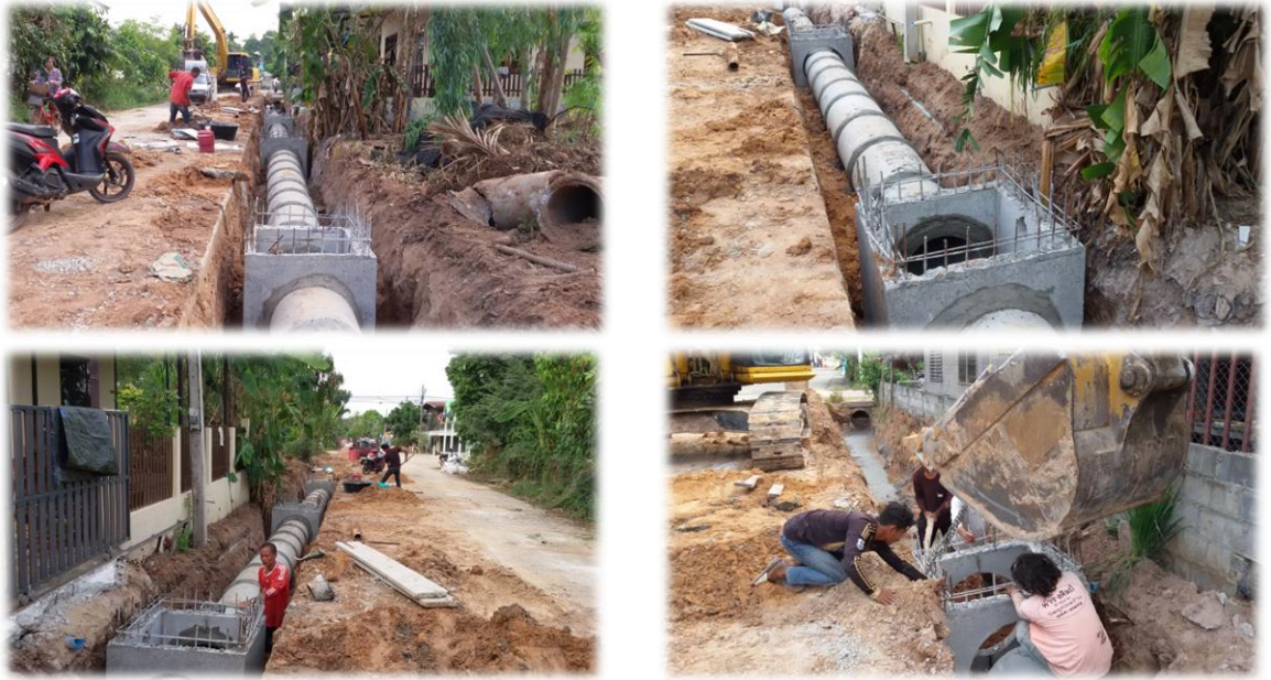
ภาพ ก่อสร้างขยายผิวจราจร และทางระบายน้ำ
