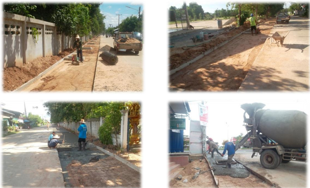
ภาพ ก่อสร้างขยายผิวจราจร และทางระบายน้ำ
