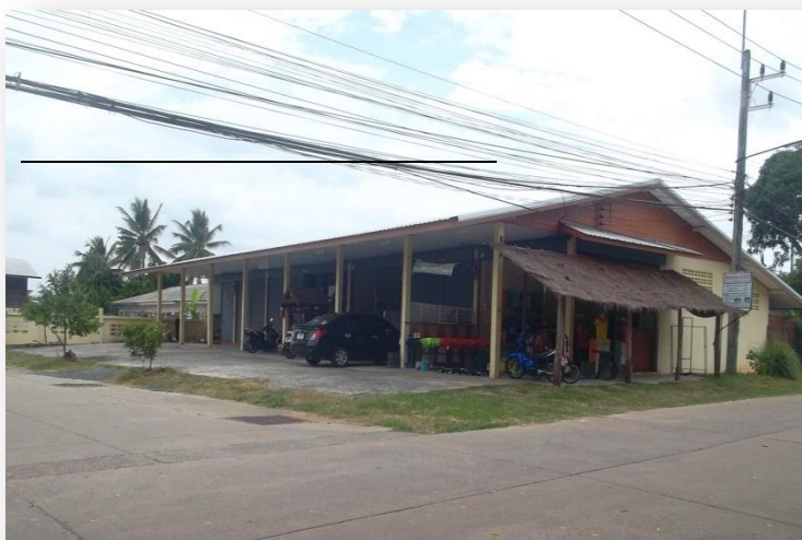
อาคารห้องแถว คสล. ชั้นเดียว
