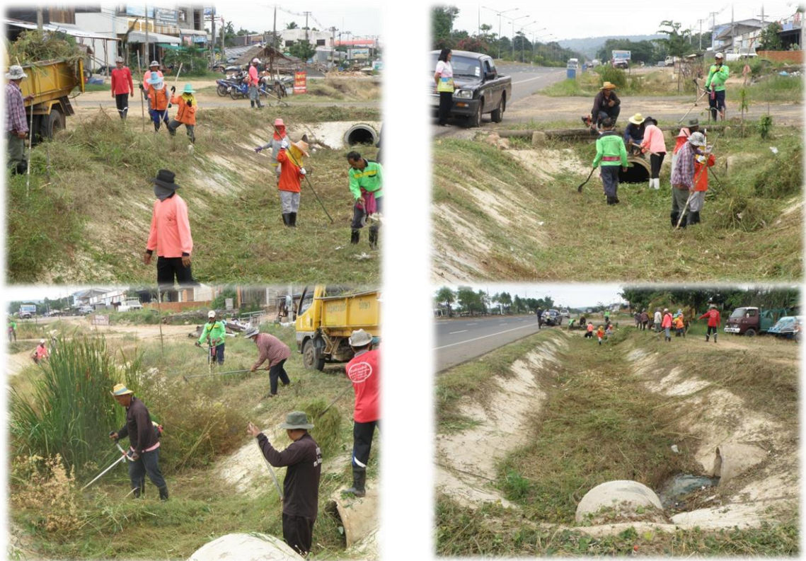
ภาพ การลอกล้างทางระบายน้ำ
